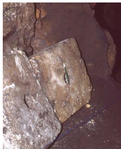
Figure 8.14. Teotihuacan water management: a. (top) facing east, 120 cm long rhyolite drain with laja fragment in front of Blockage 8 (photo by Sload 1978, © R. Millon); and b. (bottom) two drain covers at Blockage 9 (photo by Sload 1978). Figura 8.14. Manejo del agua teotihuacano: a. (arriba) viendo al este, drenaje de riolita de 120 cm de largo con fragmento de laja frente al Muro de Obstrucción 8 (foto de Sload 1978, © R. Millon); y b. (abajo) dos tapas de drenaje en el Muro de Obstrucción 9 (foto de Sload 1978).
